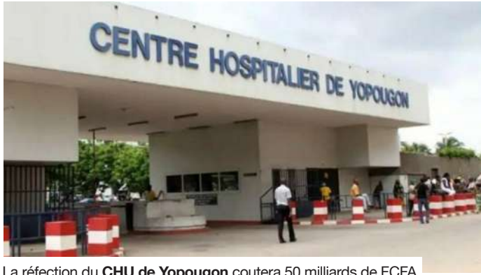
La réfection du CHU de Yopougon coûtera 50 milliards de FCFA.
